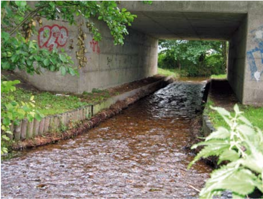
Abb. 5: Die Durchwanderbarkeit der Este ist an der B 3-Brücke hergestellt.
