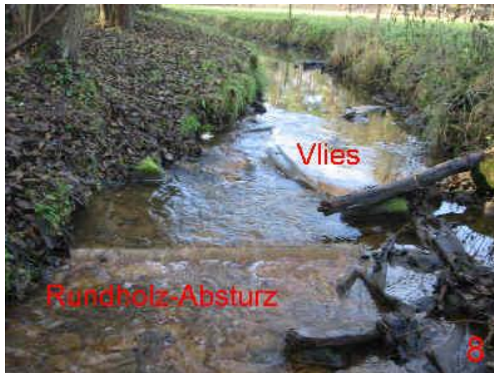
Alle Rundholz-Abstürze (Foto 8 und 9) und vorhandenes Vlies werden ausgebaut.
