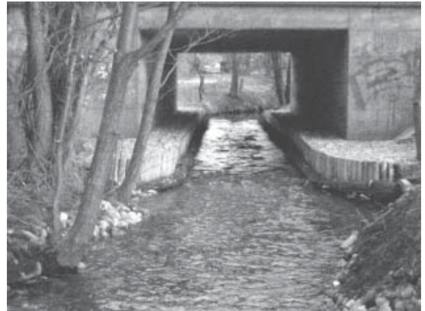
Bild 14: Die Weller Estebrücke (B3) nach dem Umbau: „Laufstege“ (Bermen) an den Ufern und ein standorttypischer Gewässergrund ermöglichen die Durchwanderbarkeit für alle Organismen
