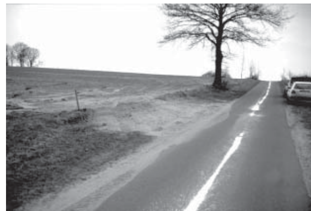
Bild 4: Erosion durch nicht angepasste Landwirtschaft, oft bereits im obersten Einzugsbereich beginnend, stellt eins der Hauptprobleme unserer Gewässer dar
